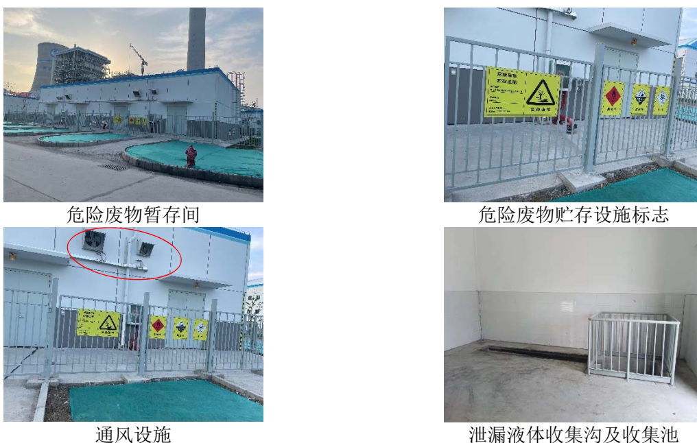
图 5.2-7 危废暂存间建设情况
